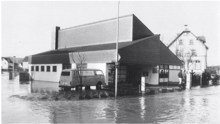
1984'er Hochwasser mit dem neuen Post Gebäude
