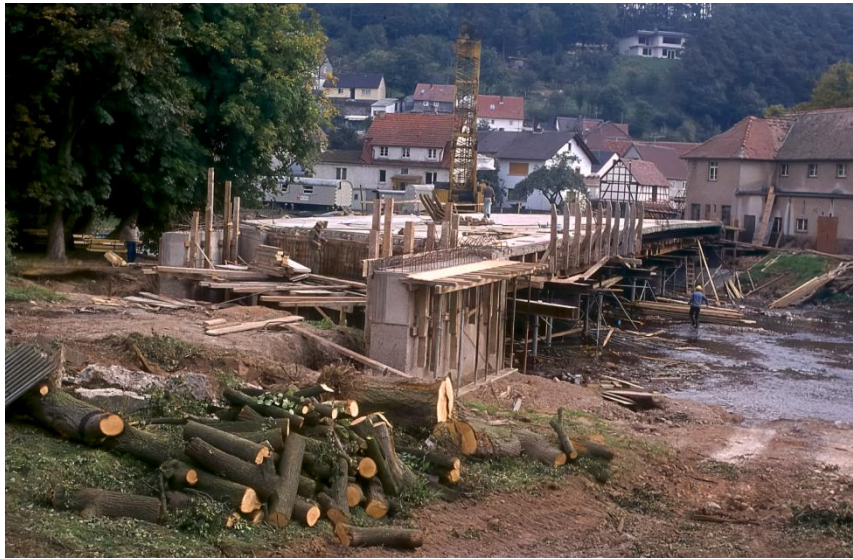
Bau der neuen Lahnbrücke, Foto: K. Tönges
