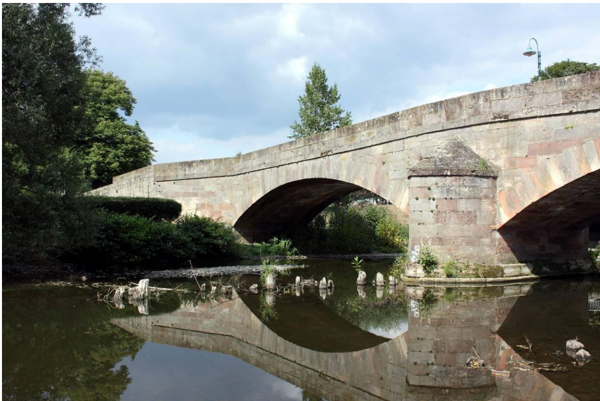
Abbildung 4: Lahnbrücke mit Resten des Eisbrechers
